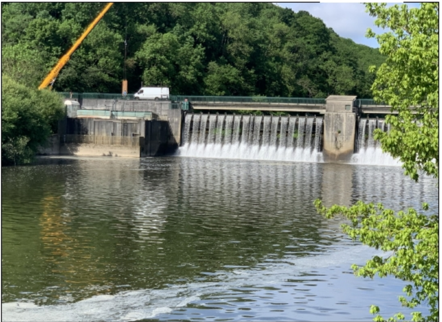
Le barrage de St Fraimbault de Prières en fonctionnement.
